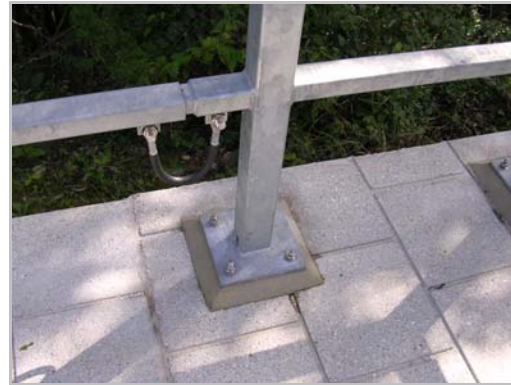
Abbildung 19: Beispiel einer Bahnerdung an Masten und Geländern
