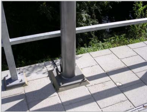
Abbildung 19: Beispiel einer Bahnerdung an Masten und Geländern
