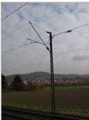
Abbildung 18: Fahrleitungsmast und elektrifizierte Strecke
